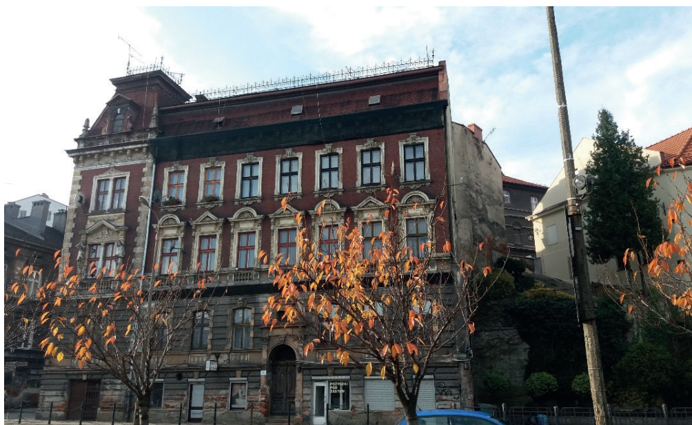
Fot. 3. Elewacja wschodnia obiektu 5. Widoczna znaczna różnica terenu będąca główną przyczyną oddziaływania wilgoci Photo 3. The eastern façade of building 5. Visible significant difference in the height of the terrain, which is the main cause of the impact of moisture
