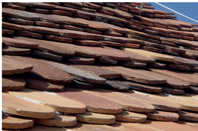
Fot. 4. Oryginalne historyczne i nowe (wykonane w tradycyjnej technologii) dachówki na jednym dachu Photo 4. Original historical and new (made using traditional technology) roof tiles on one roof
