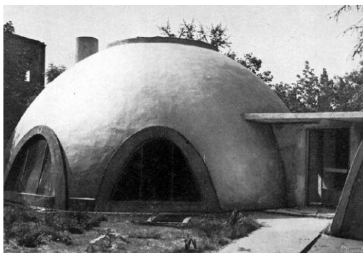
Fot. 1. Oceniany budynek w końcu lat 60. XX w. [2]
