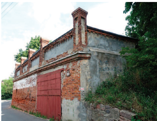
Fot. 2. Narożnik południowo-wschodni lodowni Photo 2. The south-eastern corner of the ice house
