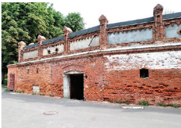
Fot. 1. Lodownia od strony południowej Photo 2. The ice house from the south
