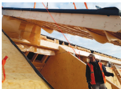
Fot. 1. Panelowa konstrukcja dachu w trakcie wykonywania Photo 1. Panel roof structure under construction
