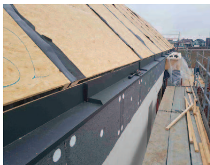
Fot. 2. Panelowa konstrukcja dachu po montażu Photo 3. Panel roof structure after erection
