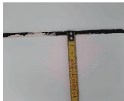
Fot. 7. Pomiar rozwarości szczeliny między płytami GKF Photo 7. Measurement of the gap between the plasterboards
