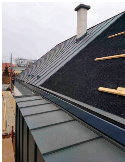
Fot. 3. Wykonywanie pokrycia dachu Photo 3. Roof covering
