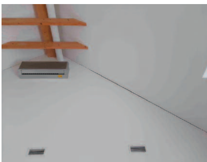
Fot. 5. Szczelina między płytami GKF na styku połaci dachowej i ściany Photo 5. Fissure between the plasterboards at the junction of the roof slope and the wall
