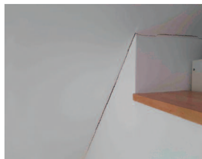
Fot. 5. Szczelina między płytami GKF na styku połaci dachowej i ściany Photo 5. Fissure between the plasterboards at the junction of the roof slope and the wall
