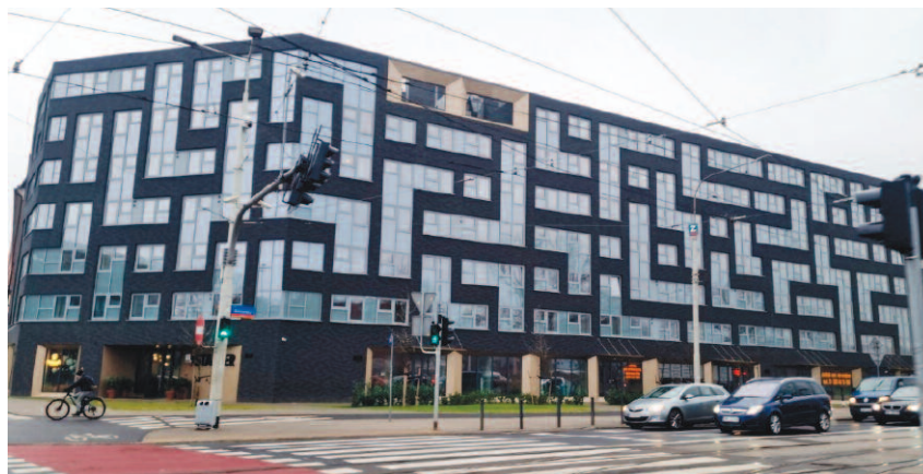
Fot. 1. Analizowany budynek Photo 1. The analysed building
