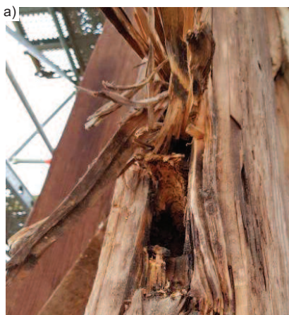
Fot. 5. Uszkodzenia mechaniczne zastrzałów hełmu: a) element przestrzelony na wylot; b) uszkodzenie powierzchniowe
