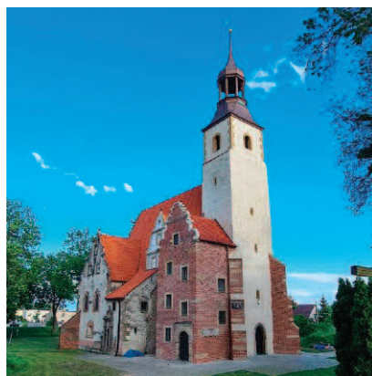
Fot. 8. Kościół po zakończonych pracach remontowych hełmu i elewacji wieży Photo 8. The church after finished renovation works of the helmet and the façade of the tower
