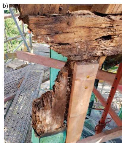
Fot. 3. Zdegradowane słupy hełmu od strony południowo-zachodniej (opis w tekście) Photo 3. The degraded helmet pillars from the south-west side (description in the article)
