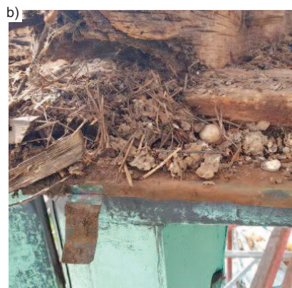
Fot. 4. Porażone elementy konstrukcyjne: a) fragment z widocznym żerowiskiem krokwiowca; b) gniazda ptactwa w miejscach połączeń konstrukcji
