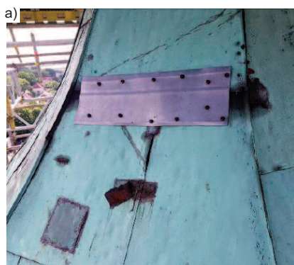
Fot. 2. Stan pokrycia z blachy miedzianej górnej części hełmu wieży: a) widoczne doraźne, nieskuteczne naprawy; b) nieszczelne połączenia i perforacja poszycia
