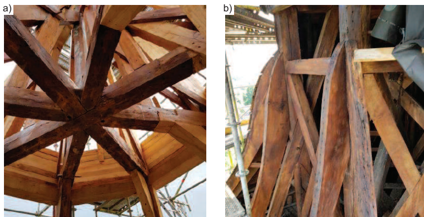
Fot. 6. Konstrukcja w trakcie prac: a) górnej części hełmu; b) dolnej części hełmu Photo 6. The structure during renovation: a) the upper part of the helmet; b) the lower part of the helmet
