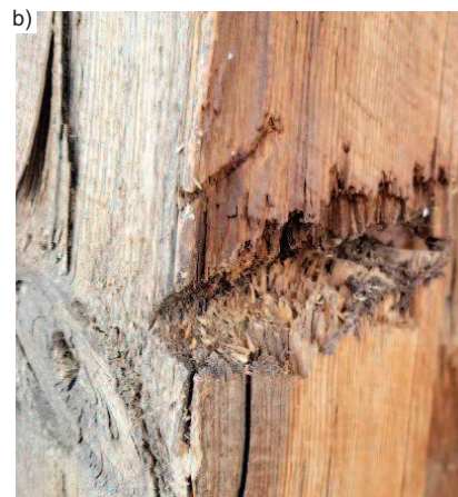
Fot. 5. Uszkodzenia mechaniczne zastrzałów hełmu: a) element przestrzelony na wylot; b) uszkodzenie powierzchniowe
