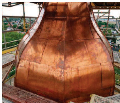
Fot. 7. Pokrycie hełmu górnego blachą miedzianą Photo 7. The upper part of the helmet with a copper sheet
