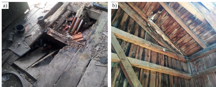
Fot. 4. Budynek magazynu: a) podłoga; b) więźba dachowa Photo 4. Warehouse building: a) floor; b) roof trusses
