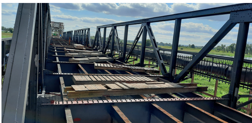
Fot. 3. Remont płyty pomostowej Photo 3. Renovation of the bridge deck
