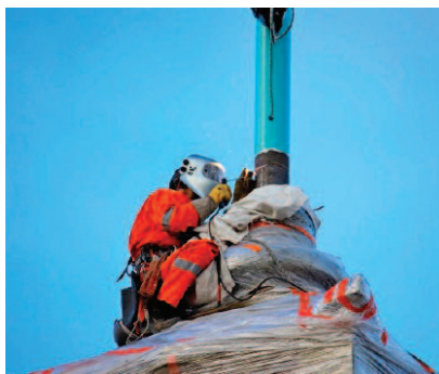
Fot. 3. Montaż konstrukcji iglic Photo 3. Installation of spire structures
