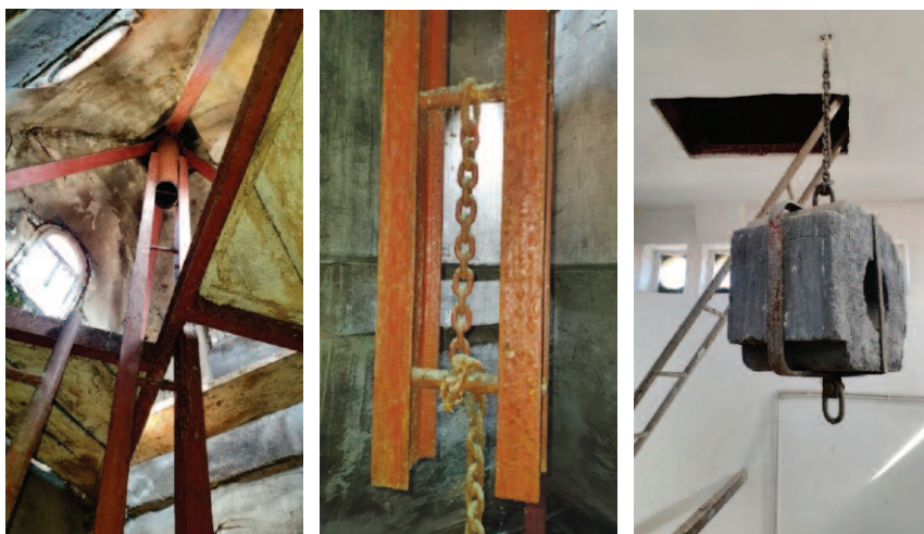
Fot. 1. Górny węzeł oraz konstrukcja podtrzymująca iglice Photo 1. Top knot and needle support structure
