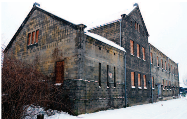
Fot. 1. Widok na elewację południową i wschodnią. Stan przed adaptacją na funkcje muzealne. Na pierwszym planie ujęcia koziół oporowy na zakończeniu bocznic kolejowej Polskiego Monopolu Tytoniowego
