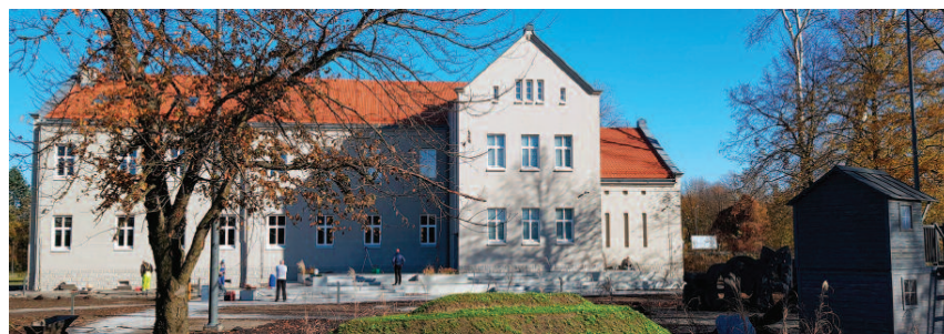
Fot. 3. Elewacja zachodnia z dobudowaną nową kubaturą, w której znajduje się nowa główna klatka schodowa z windą
