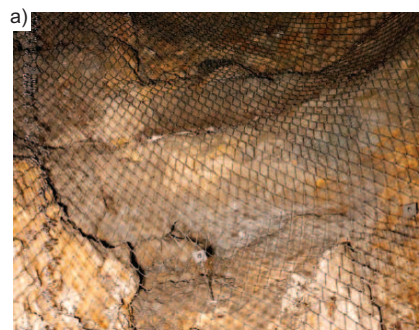
Fot. 5. Dodatkowe zabezpieczenia masywu skalnego Smoczej Jamy: a) zabezpieczenie siatką ze stali nierdzewnej; b) zabezpieczenie podporową obudową kamienną Photo 5. Additional protection of the Dragon's Den: a) stainless steel wire mesh protection; b) stone support protection
