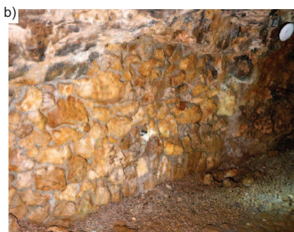
Fot. 5. Dodatkowe zabezpieczenia masywu skalnego Smoczej Jamy: a) zabezpieczenie siatką ze stali nierdzewnej; b) zabezpieczenie podporową obudową kamienną Photo 5. Additional protection of the Dragon's Den: a) stainless steel wire mesh protection; b) stone support protection
