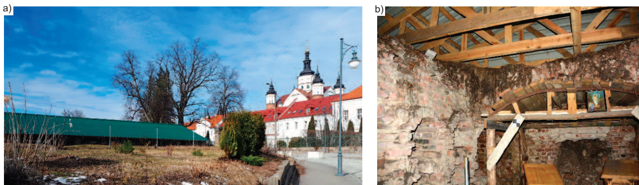
Fot. 2. Tymczasowa konstrukcja przekrywająca katakumby: a) widok dachu (zielony) na tle klasztoru; b) pas dolny kratownicy gwoździowanej
