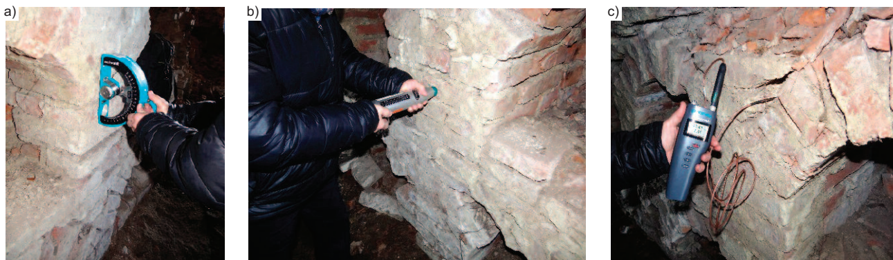
Fot. 5. Badania nieniszczące struktury murów: a) pomiar liczby odbicia młotkiem wahadlowym; b) pomiar liczby odbicia młotkiem typu L; c) pomiar wilgotności w głębi muru
