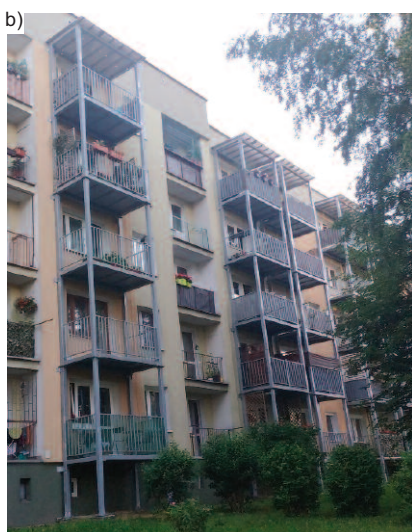
Fot. 5. Remonty balkonów: a) wymiana wszystkich warstw i balustrad; b) wykonanie nowych balkonów na konstrukcji dostawianej do budynku
