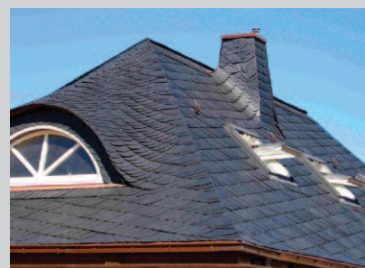
Fot. 2. Dach pokryty łupkiem ułożonym w stylu staroniemieckim, który pozwala na wykonanie bardzo wysokich doświetleń typu „wole oko”
