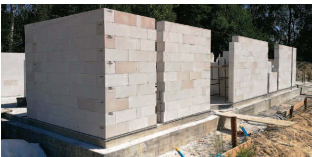
Mury z ABK mogą być wykonane z materiałów różnego asortymentu
