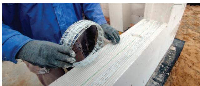
Zbrojenie jest ważnym elementem muru
