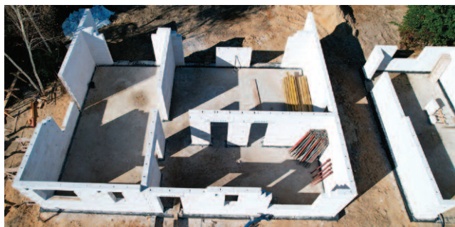
Przed rozpoczęciem budowy należy ustalić, co będzie potrzebne do wznoszenia ścian
