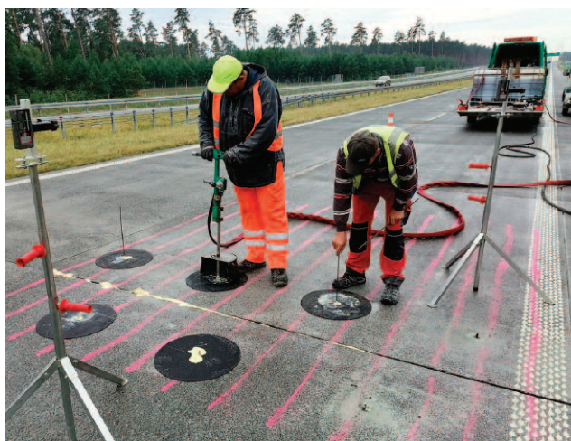
Fot. 2. Tłoczenie geopolimeru pod płytę betonową
