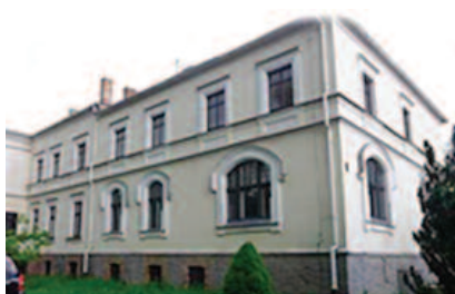
Fot. 2. Dwór w Skrzynkach po zakończeniu robót remontowych Fot.: E. Siejek Photo 2. The court in Skrzynki after the completion of restoration works Photo E. Siejek
