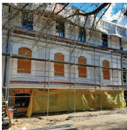
Fot. 1. Roboty dociepleniowe Fot. E. Siejek Photo 1. Thermal insulation works Photo E. Siejek
