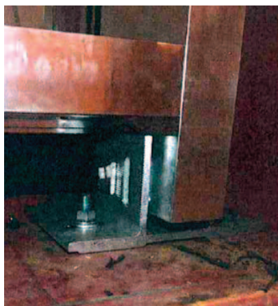
Fot. 2. Detal podparcia słupa ściany na ramie stalowej mocowanej do stanowiska badawczego
