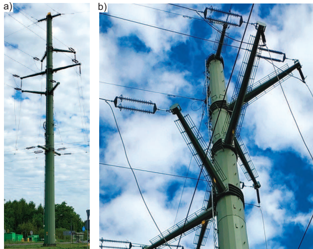
Fot. 1. Słup powłokowy linii 110 kV: a) widok ogólny; b) gniazda Photo 1. Shell pole of 110 kV transmission line: a) general view; b) sockets
