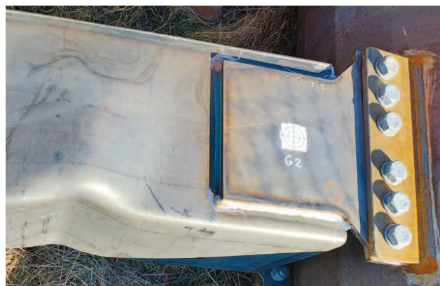
Fot. 3. Deformacja konstrukcji po badaniach Photo 3. Structure deformation after tests
