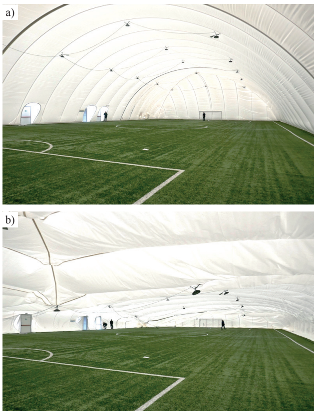
Fot. 2. Widok opadającej powłoki hali podczas jednej z prób: a) początkowy; b) po 15 minutach próby [opracowanie własne] Fig. 2. View of the falling shell of the hall during one of the tests: a) initial; b) after 15 minutes of the test
