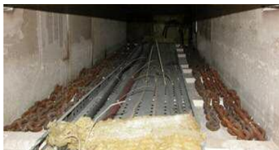
Fot. 1. Wnętrze kanału kablowego przed badaniem [źródło: archiwum ITB] Photo 1. Interior of cable duct prior to the test
