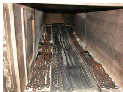
Fot. 2. Wnętrze kanału kablowego po badaniu [źródło: archiwum ITB] Photo 2. Interior of cable duct after the test
