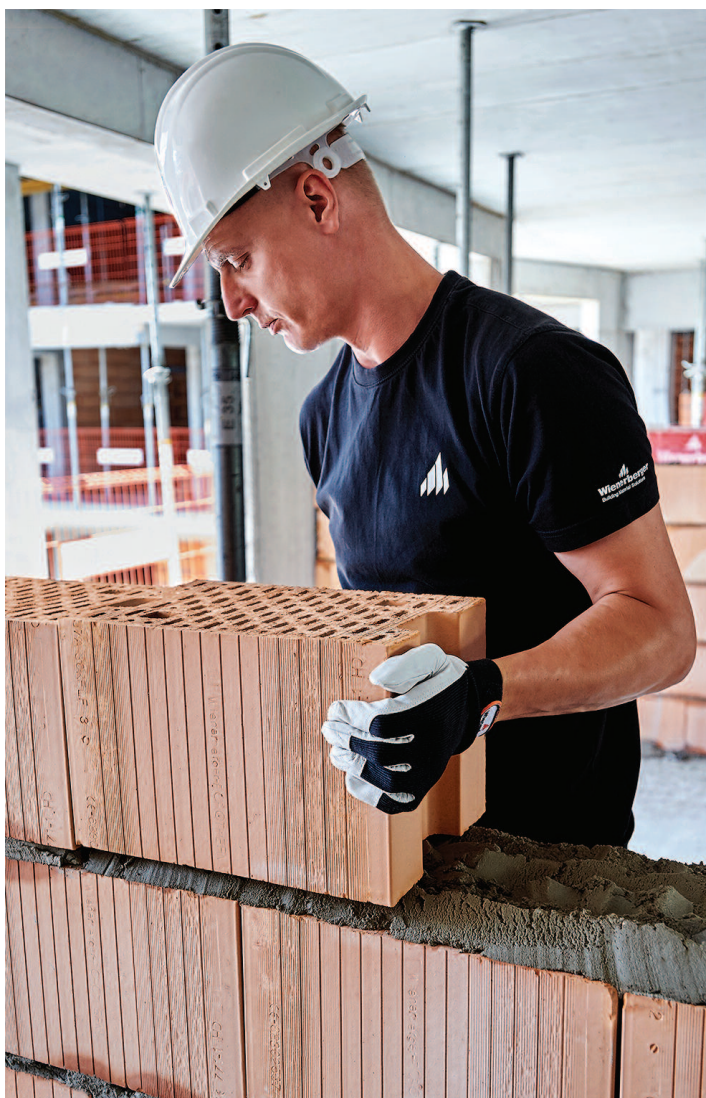
Wznoszenie ściany jednowarstwowej z pustaka Porotherm 25/37.5 AKU
