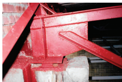
Fot. 2. Szczegół węzła podporowego wiązara (podczas prac antykorozyjnych) [8] Photo 2. Detail of the girder support node (during anti-corrosion works) [8]
