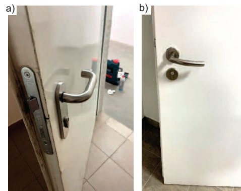
Fot. 7. Klamka zgodna z normą dotyczącą okuć na drogach ewakuacyjnych PN-EN 179:2009 – zalecana (a); klamka z prosto zakończoną rękojeścią niezgodna z normą do okuć na drogach ewakuacyjnych PN-EN 179:2009 (b)
