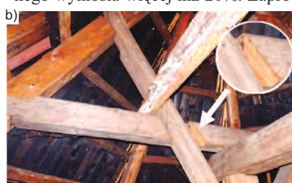
Fot. 6. Ubytki w przestrzeni strychowej: a) nieszczelności pokrycia dachowego; b) niedopasowane, zbyt duże gniazdo ciesielskie
