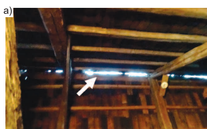
Fot. 6. Ubytki w przestrzeni strychowej: a) nieszczelności pokrycia dachowego; b) niedopasowane, zbyt duże gniazdo ciesielskie
