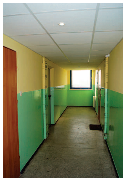
Fot. 3. Sufit podwieszany na korytarzu budynku wysokiego
