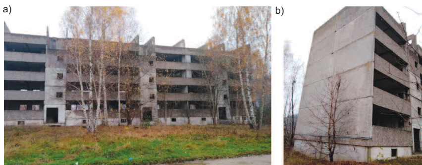
Fot. 1. Nieukończony budynek: a) elewacja frontowa; b) ściana szczytowa Photo 1. The unfinished building: a) front view; b) curtain wall
