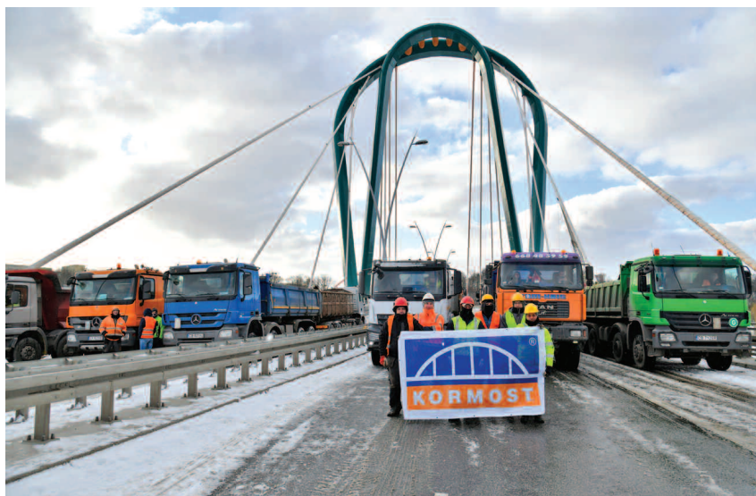
Próbné obciążenie Mostu Uniwersyteckiego w Bydgoszczy – 21 stycznia 2022 r.
