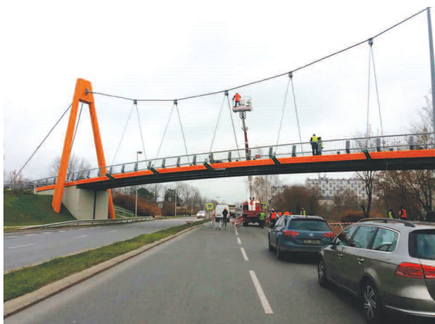
Analizowana kładka dla pieszych w Rzeszowie The analyzed footbridge localized in Rzeszów
