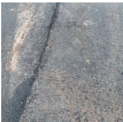
Fot. 3. Połączenie między działkami roboczymi Photo 3. Joint between the working plots
