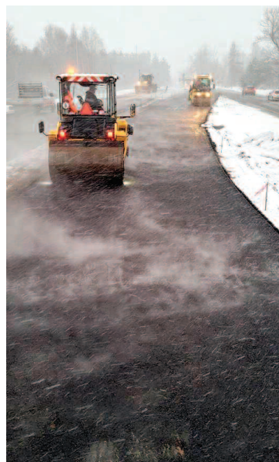
Fot. 1. Roboty bitumiczne w warunkach zimowych
