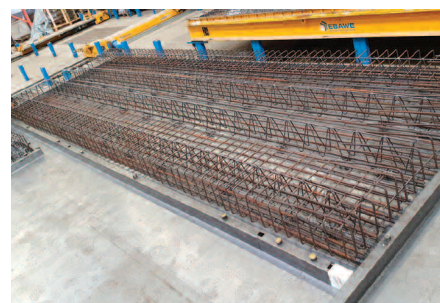
Fot. 3. Zbrojenie płyty szalunku traconego FILIGRAN
