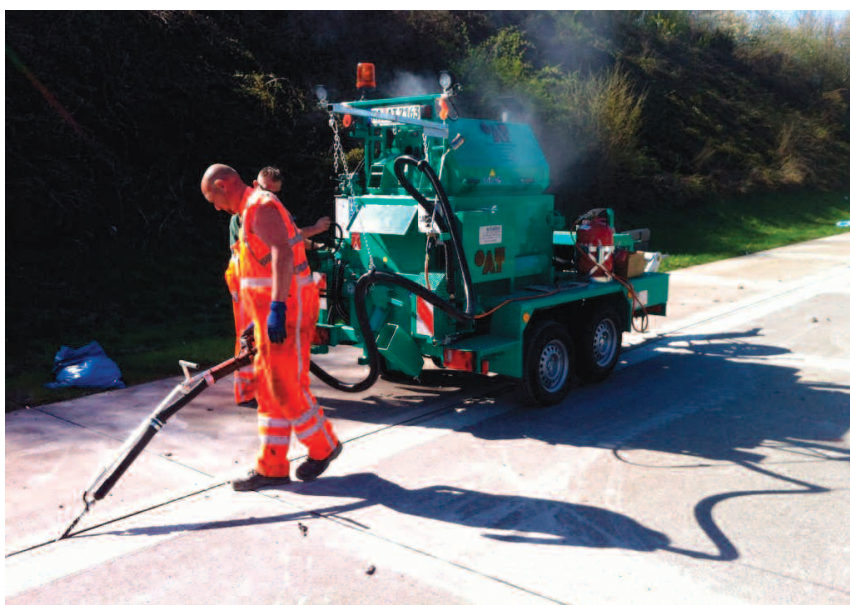
Wypełnianie szczelin masą zalewową na gorąco
