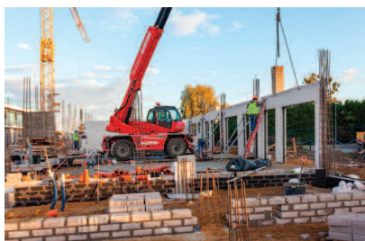
Fot. 3. Montaż prefabrykowanych ścian zespolonych Betard; początkowa koncepcja staje się realną konstrukcją
