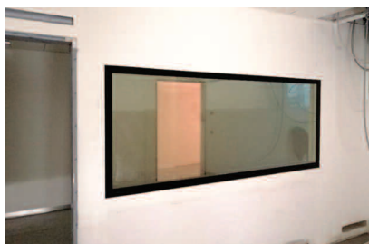
Fot. 2. Ściana wewnętrzna z szybą ołowianą chroniącą przed promieniowaniem rentgenowskim
