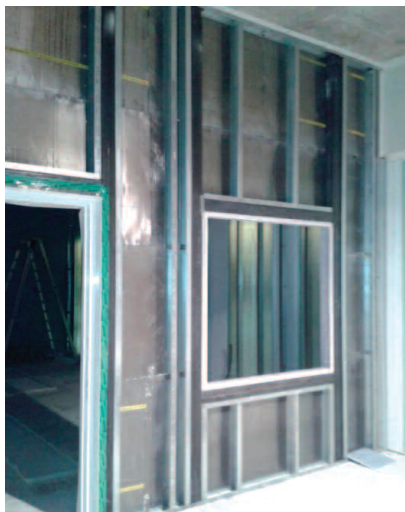
Fot. 1. Wypełnienie blachą ołowianą ściany wewnętrznej
