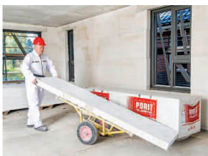
Fot. 3. Montaż prefabrykowanych zbrojonych paneli ściennych z betonu komórkowego https://www.porit.de Photo 3. Installation of prefabricated reinforced wall panels
