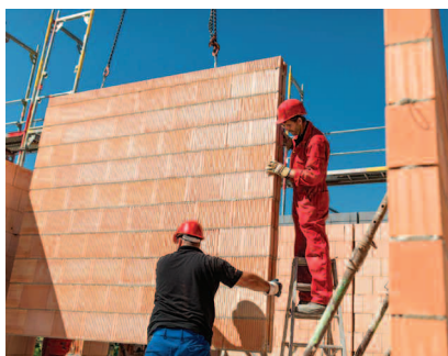
Rys. 2. Montaż prefabrykowanych ścian murowanych www.staudacher-ziegel.de Fig. 2. Installation of prefabricated brick walls
