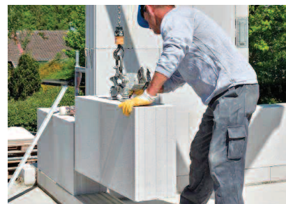
Fot. 1. Murowanie z wielkowymiarowych elementów silikatowych www.ks-original.de Photo 1. Bricklaying with large-size silicate elements
