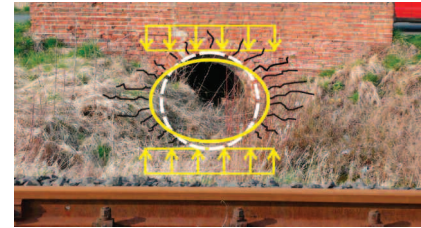
Fot. 1. Ideowy schemat degradacji obiektu na przykładzie przepustu komunikacyjnego Photo 1. Idealized scheme of structure degradation on the example of road culvert under live load
