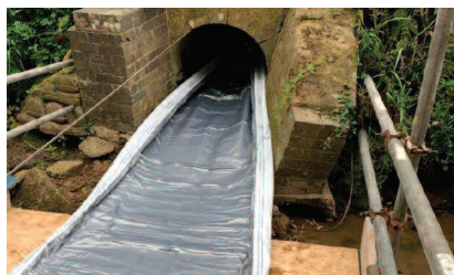
Fot. 3. Przykład zastosowania technologii CIPP – rękawa utwardzanej na miejscu do renowacji przepustu zabytkowego w Wielkiej Brytanii [7]
