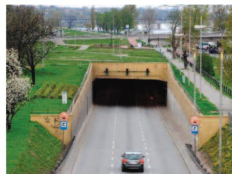
Fot. 3. Wjazd do tunelu Wisłostrady [6]
