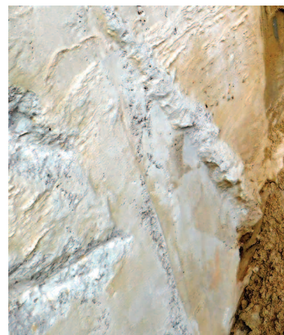
Widok ściany szczelinowej View of diaphragm wall
