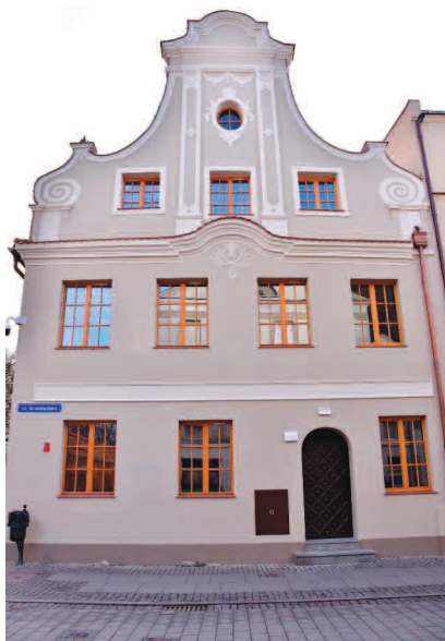
Fot. 2. Fasada kamienicy w Chełmnie po modernizacji Fot. K. Plachta Photo 2. Facade of the building in Chełmno after modernisation Photo K. Plachta
