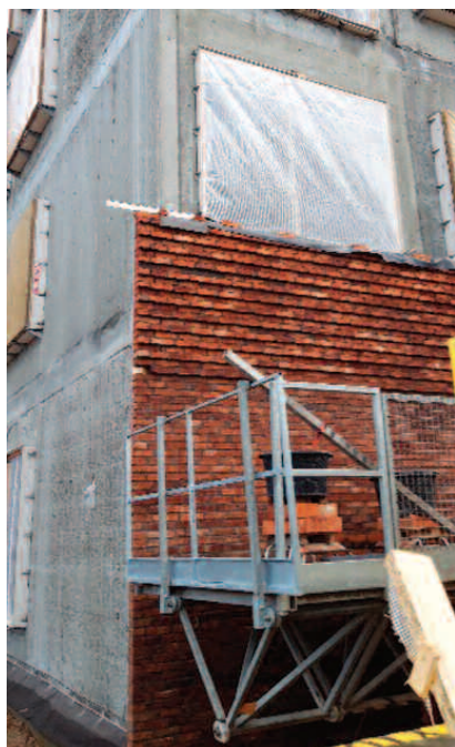
Fot. 2. Standardowe wykonywanie izolacji termicznej w budynkach mieszkalnych w Danii – ściana trójwarstwowa z osłoną murowaną z cegły ceramicznej Photo 2. Standard placement of thermal insulation in Denmark – a three-layer wall with cover made of ceramic brick
