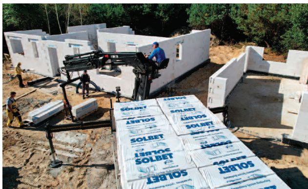
Budowa w systemie SOLBET
