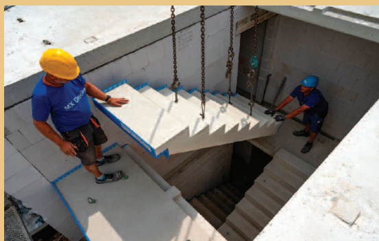
Montaż prefabrykowanego biegu schodowego zabezpieczonego akustycznie za pomocą systemu Schöck Tronsole®
