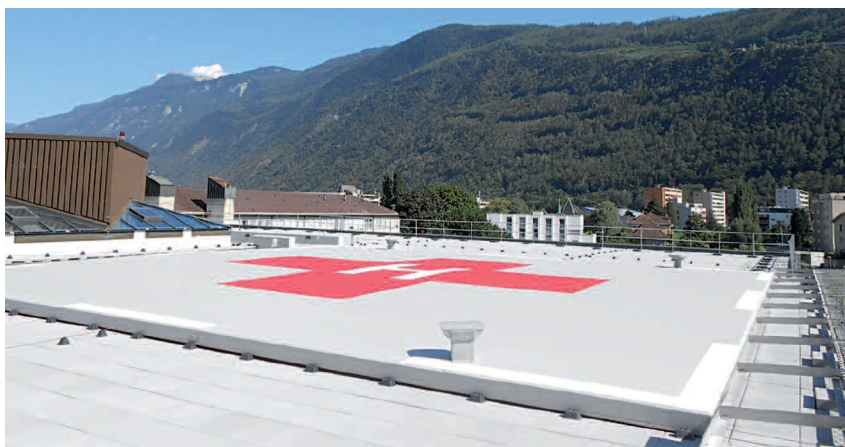
ALSAN® 770 TX w funkcji izolacji lądowiska dla helikopterów sanitarnych w Marigny we Francji
