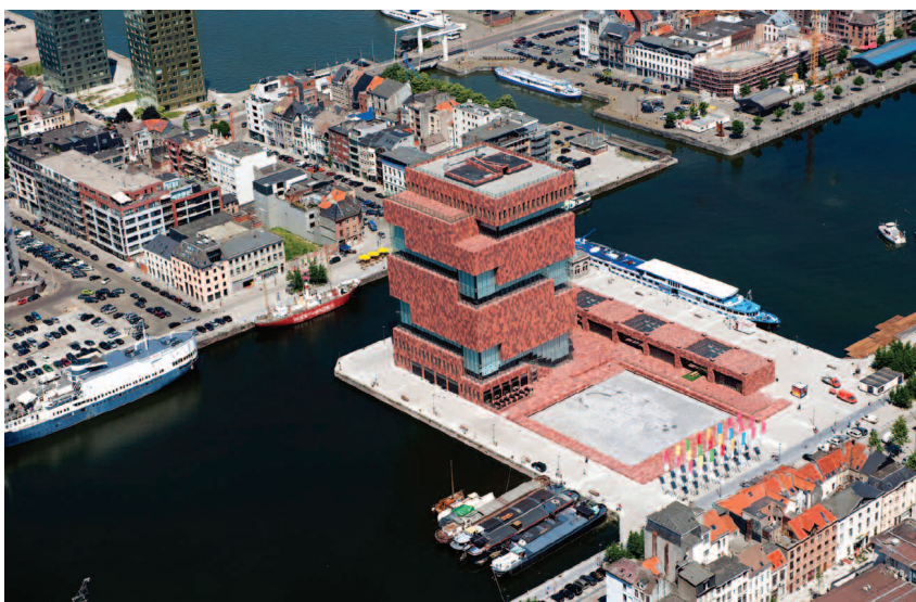
Museum aan de Stroom (Muzeum na rzece), Antwerpia. Architekci: Willem Jan Neutelings, Michiel Riedijk. Do hydroizolacji dachu użyto jednoskładnikowej, wodoszczelnej żywicy poliuretanowej ALSAN® FLASHING QUADRO firmy SOPREMA
