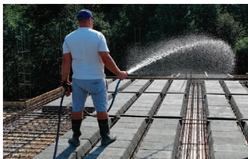
Fot. 1. Najwięcej wilgoci pochodzi z technologii mokrych, przygotowania robót i pielęgnacji betonu
