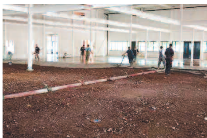
Fot. 3. Układanie bezspoinowej posadzki na palach; zbrojenie Dramix® 5D 65/60BG w ilości 30 kg/m 3 , beton C28/35, grubość 180 mm
