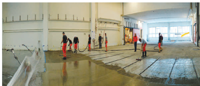
Wylewanie i zacieranie Sika® Screed HardTop 65
