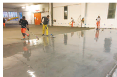
Gruntowanie Sikafloor® 151 + Sikafloor® 54 Booster
