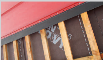
Fot. 2. Dach pokryty stalowymi panelami zatraskowymi z dwoma warstwami membrany: jedna działa jako MWK, a druga jest ułożona między „półdeskowaniem” a panelami i pełni funkcję warstwy poślizgowo-rozdziałającej
