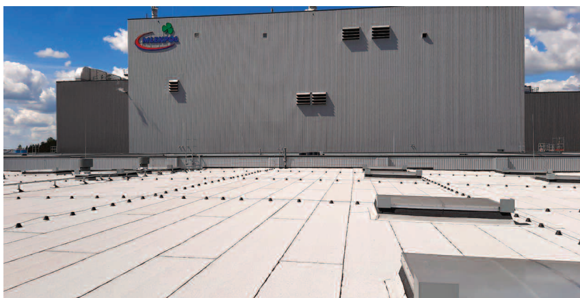
Zakłady produkcyjne Mlekoop w Mrągowie są przykładem zastosowania innowacyjnych systemów SOPREMA do renowacji dachów płaskich, gdzie wykorzystano papy bitumiczne SOPRALENE FLAM 180 AR CHAGALL z białym łupkiem, zapobiegające nagrzewaniu się dachu
