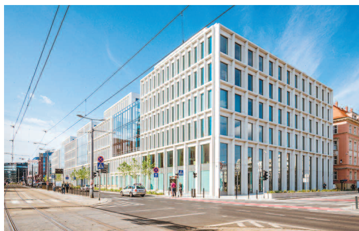
Fot. 5. III nagroda – budynek biurowo-usługowy „Nowy Targ” we Wrocławiu
